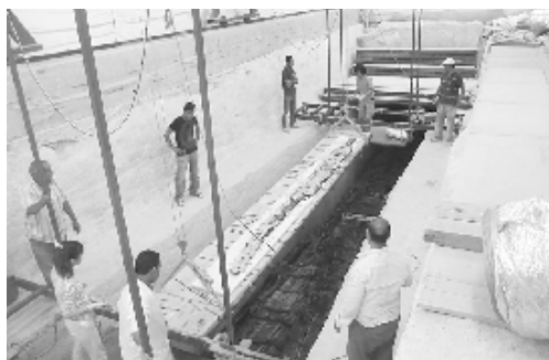
図9 ピットからの部材の取り上げ。エレベーター、クレーンを用い、部材を1点ずつ丁寧に取り上げる。
